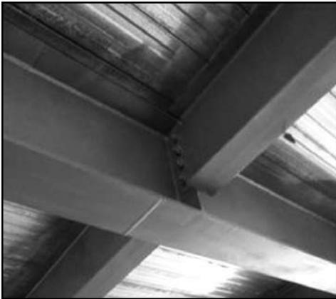
Conexión entre correa y viga principal en entrepiso compuesto de acero-concreto.
