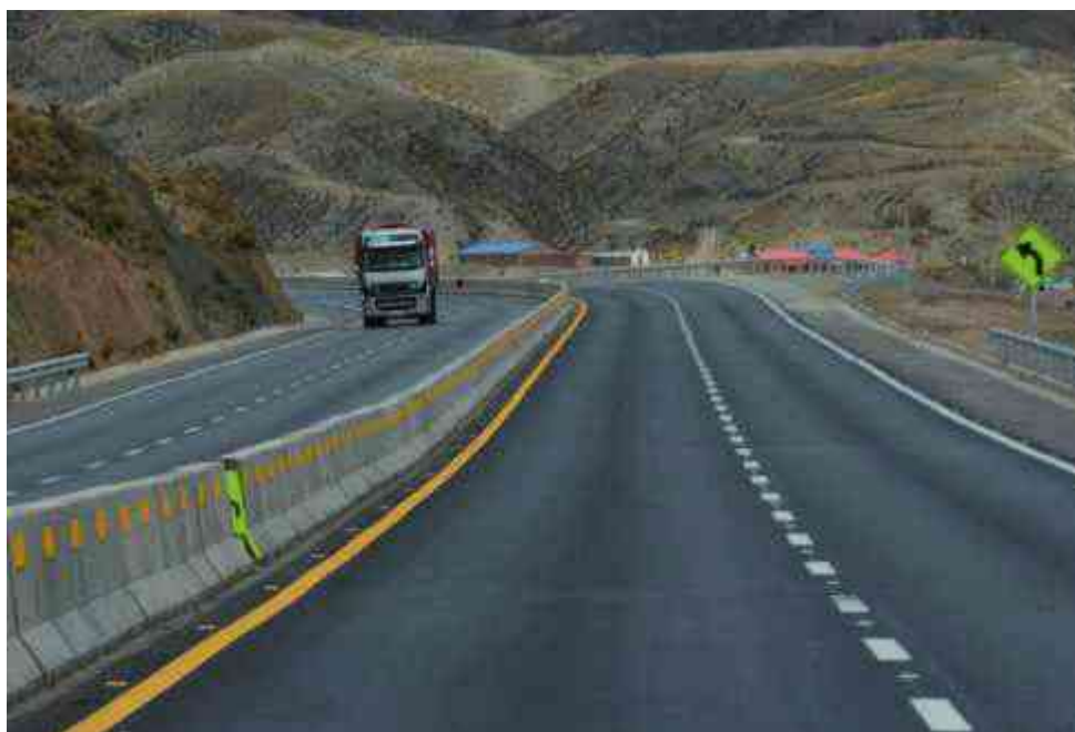
Doble vía Cochabamba – Oruro (Tramo: Confital-Caracollo)
