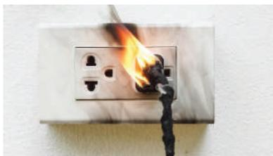
Los tomacorrientes son también puntos de riesgos para la seguridad una vez que estén dañados o desgastados. Tome un momento para inspeccionar la temperatura de las placas en los tomacorrientes. Si una placa está tibia o caliente al tacto, podría indicar un problema de cableado grave que debe investigarse más a fondo por un electricista calificado.
