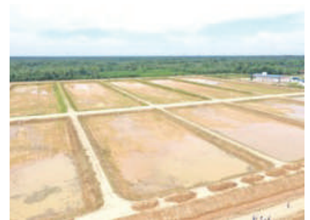
Construcción del complejo piscícola en Chimoré
